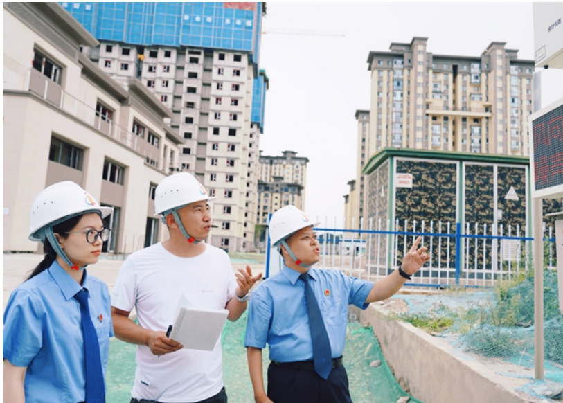
6月6日,昌吉市人民检察院干警走访工地,了解噪声监测情况。
