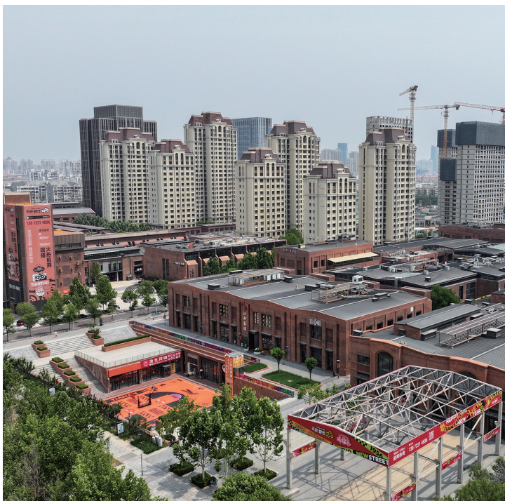
天津天拖片区城市更新项目(5月30日摄,无人机照片)。
