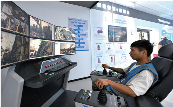
塔吊操作员通过远程操控进行天津南门外大街商圈北部片区城市更新项目施工(5月29日摄)。
