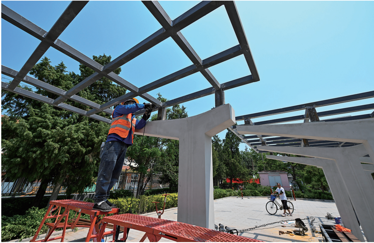
工人在天津天拖片区城市更新项目淦江西里社区内修建公共设施(5月28日摄)。
