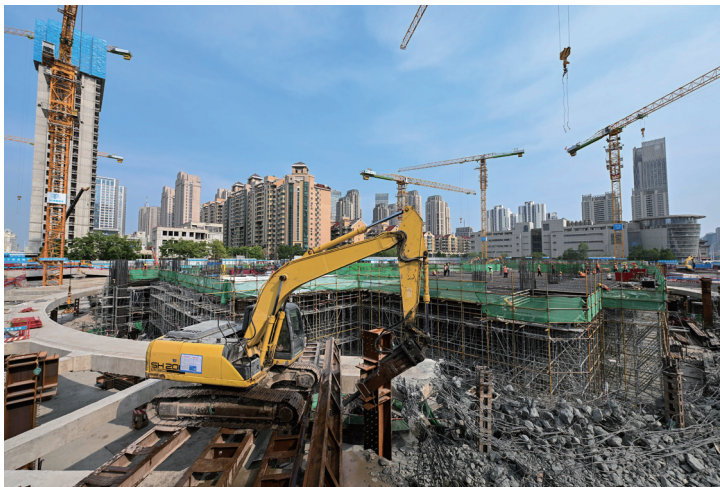
天津南门外大街商圈北部片区城市更新项目建设现场(5月29日摄)。
