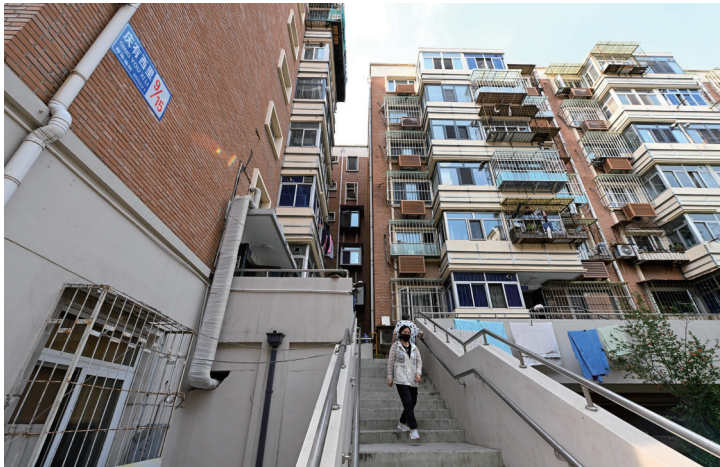
天津南门外大街商圈北部片区城市更新项目改造翻新后的庆有西里社区(5月29日摄)。
