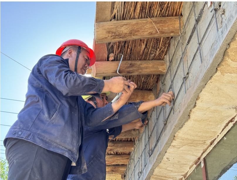
工人正在对房屋进行墙面加固。
