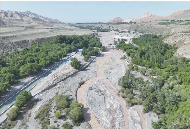
6月12日，玛纳斯县塔西河干渠改造提升项目正式建成通水。 □朱文斌摄
