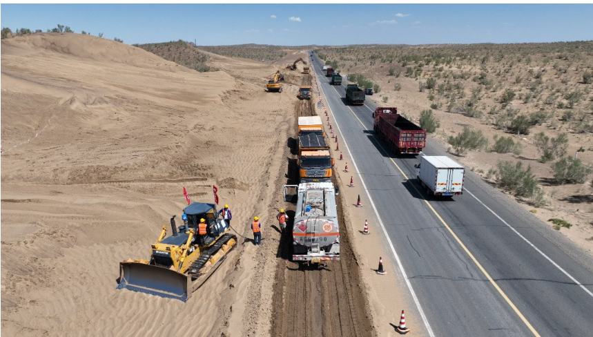
近日，在吉木萨尔县 S239 线五彩湾至吉木萨尔县公路改扩建项目施工现场，施工人员进行路基施工、挖方作业。 □马凯雄摄
