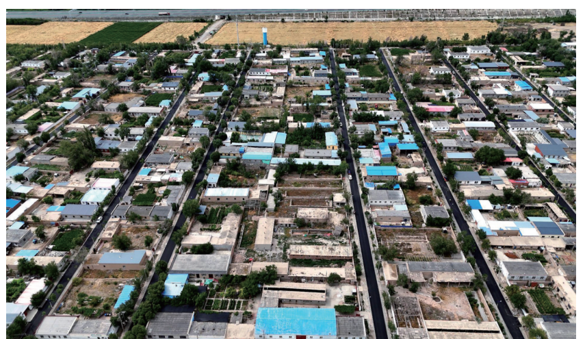
凉州户镇庄浪户村道路已摊铺上沥青。
