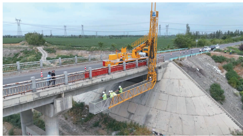
近日，在玛纳斯县六阜河大桥检测现场，技术人员运用专业设备对桥梁各关键部位进行系统勘查。 □张海洋摄
