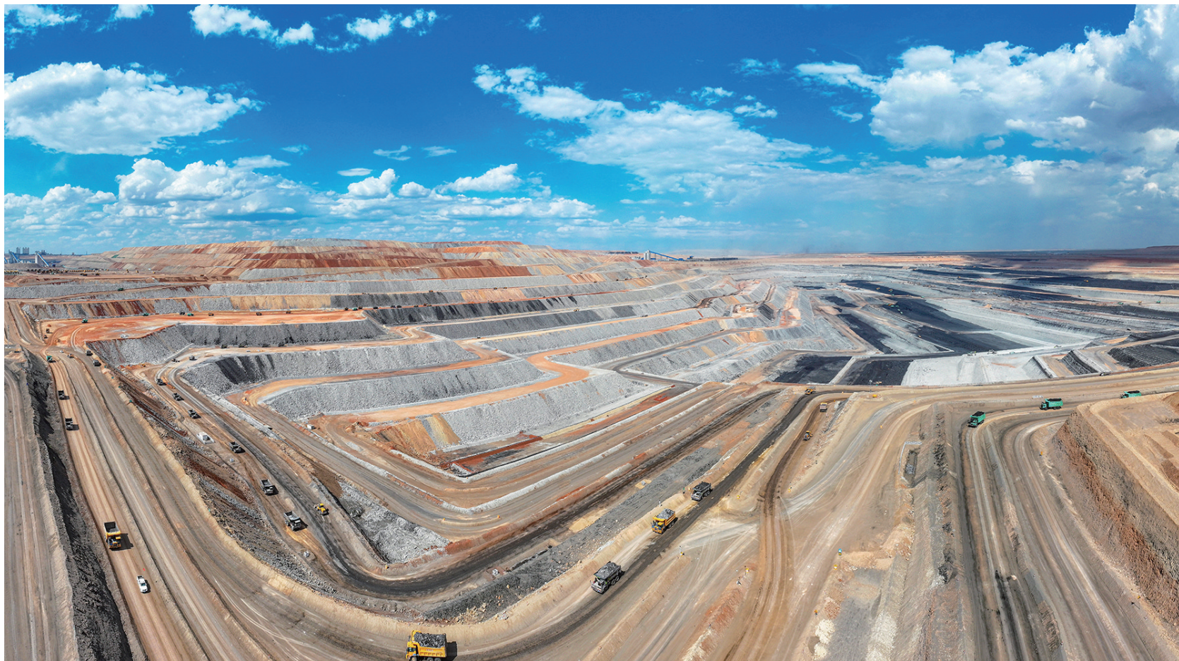
8月4日,准东经济技术开发区西黑山矿区,国能新疆红沙泉能源有限责任公司红沙泉一号露天煤矿作业现场。近年来,国能新疆红沙泉能源有限责任公司红沙泉一号露天煤矿进一步提升生产效率和安全性,积极引入无人驾驶矿卡、北斗高精度定位系统、5G智能采煤系统等先进技术,建成智能云控平台,实现生产调度全流程自动化、设备运行数据实时监控及安全预警精准化,为矿山的安全生产提供了可靠技术支持。 □本报记者 何龙摄
