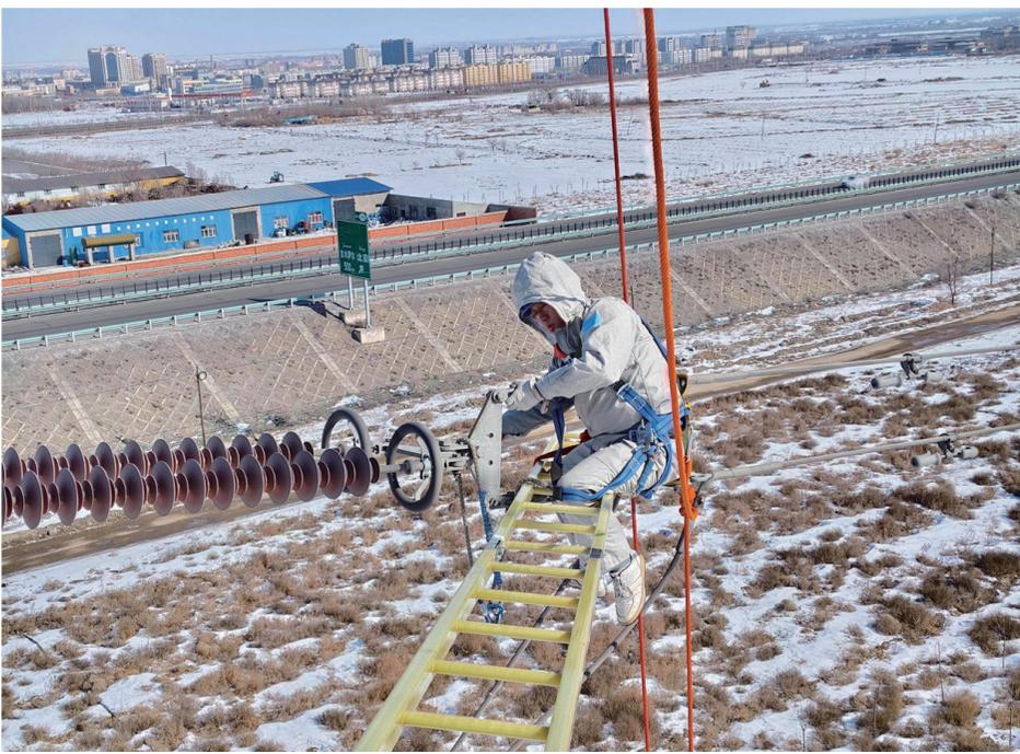
国网昌吉供电公司输电运检中心带电作业班班长马文杰在220千伏池幸二线98号塔采用带电作业方式进行消缺处理。图片由国网昌吉供电公司提供
