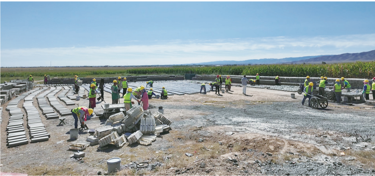
近日,新户镇三畦村“以工代赈”项目施工现场,工人们互相配合制作路缘石。
