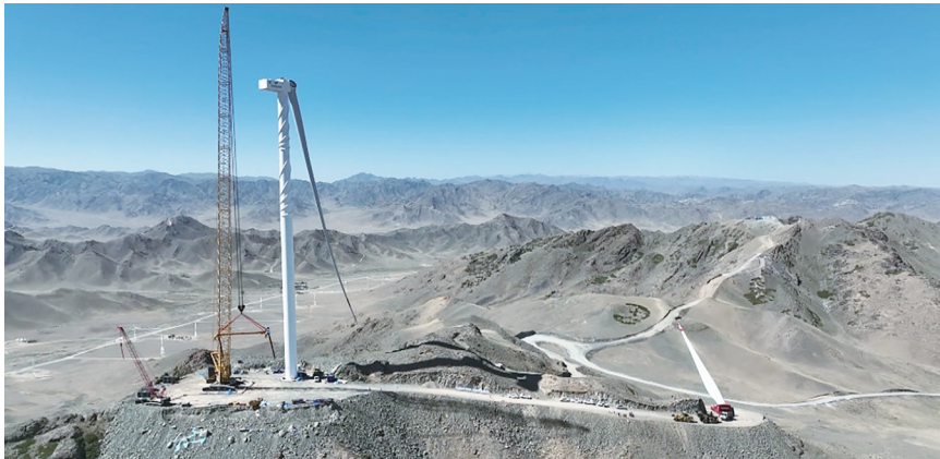
无人机镜头里的中电神火自备绿电替代风电项目建设现场。
