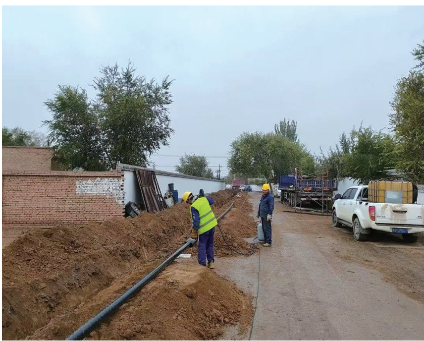
这是2024年昌吉市榆树沟镇榆树沟村清洁取暖煤改气项目施工现场。图片由昌吉州住建局提供
