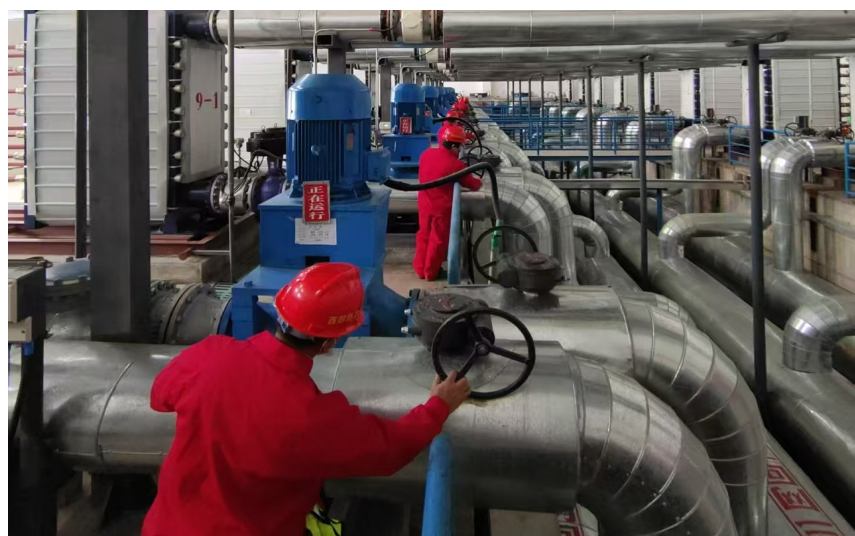
工人们在供暖前对设备进行冷态试运行的检查消除。 □肖娅洁摄
