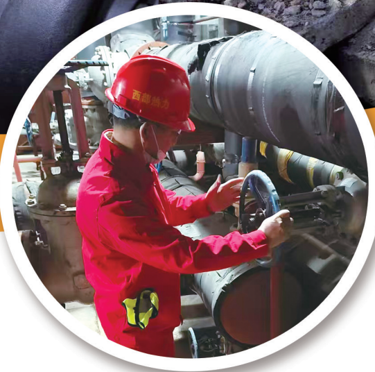
▲工人在检查设备。 □肖娅洁摄
