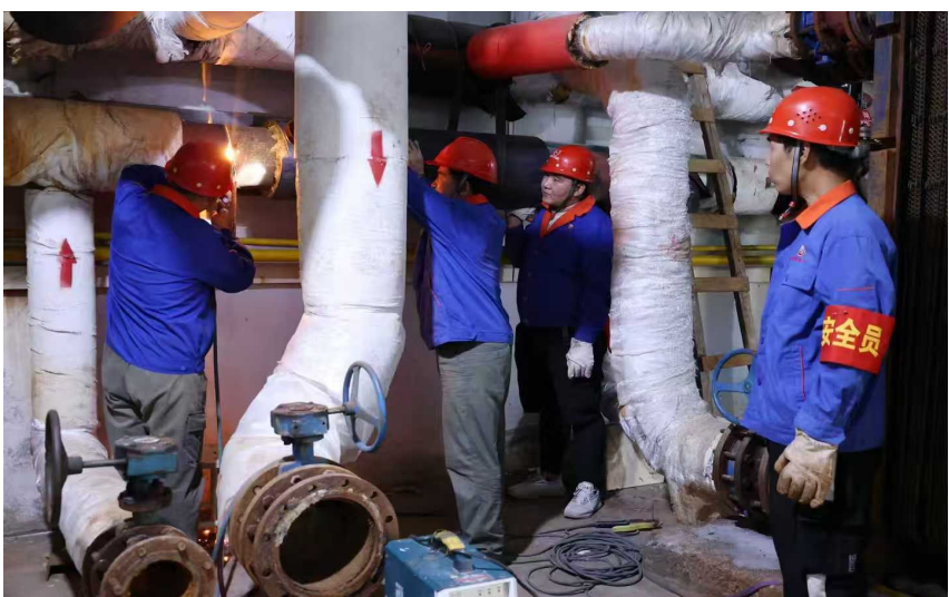
工人们在焊接供水管。 □付小芳摄
