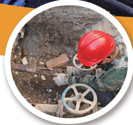
▲工人在筛查被腐蚀的进水管。 □肖娅洁摄
