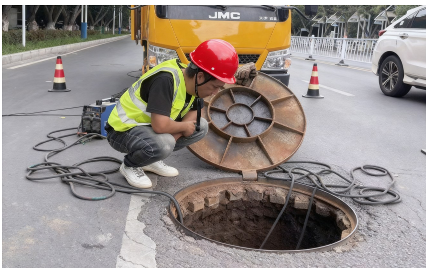
工人在检测供热管网。 □肖娅洁摄
