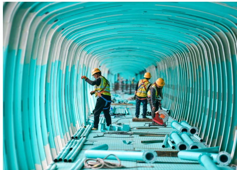
上图:2025年6月11日,工人在贵州花江峡谷大桥上安装观景长廊。
