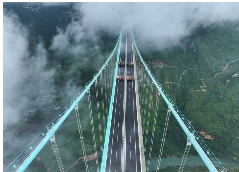
2025年8月21日拍摄的贵州花江峡谷大桥荷载试验现场(无人机照片)。
