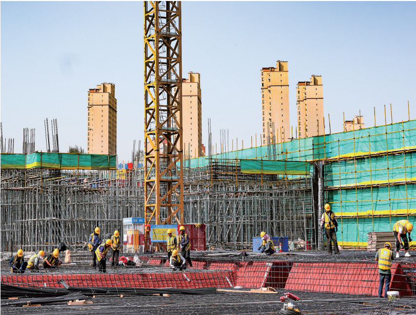
近日，工人在新疆华美胜地昌吉金普顿酒店集群项目现场施工。
