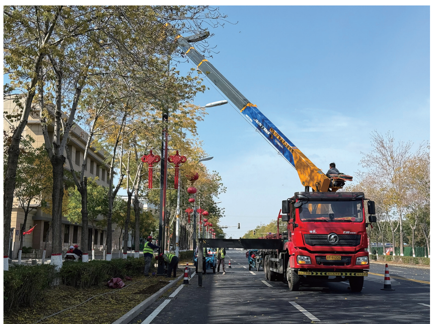
近日，呼图壁县市政工人在新提升改造后的东风大街更换沿街路灯。 □吾拉恩·巴合提努尔摄
