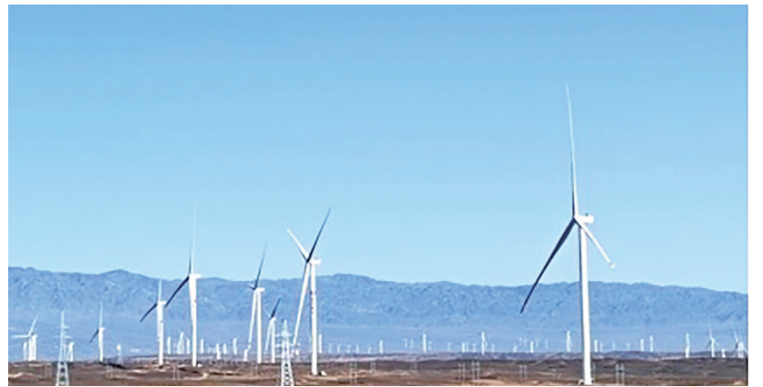
图为昌吉国投奇台县180万千瓦风光氢储一体化项目一期项目现场。 □李佳佳摄
