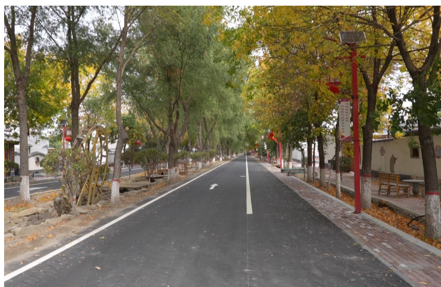
新改建的玛纳斯国家湿地公园环线公路兰州湾镇八家户村段。
