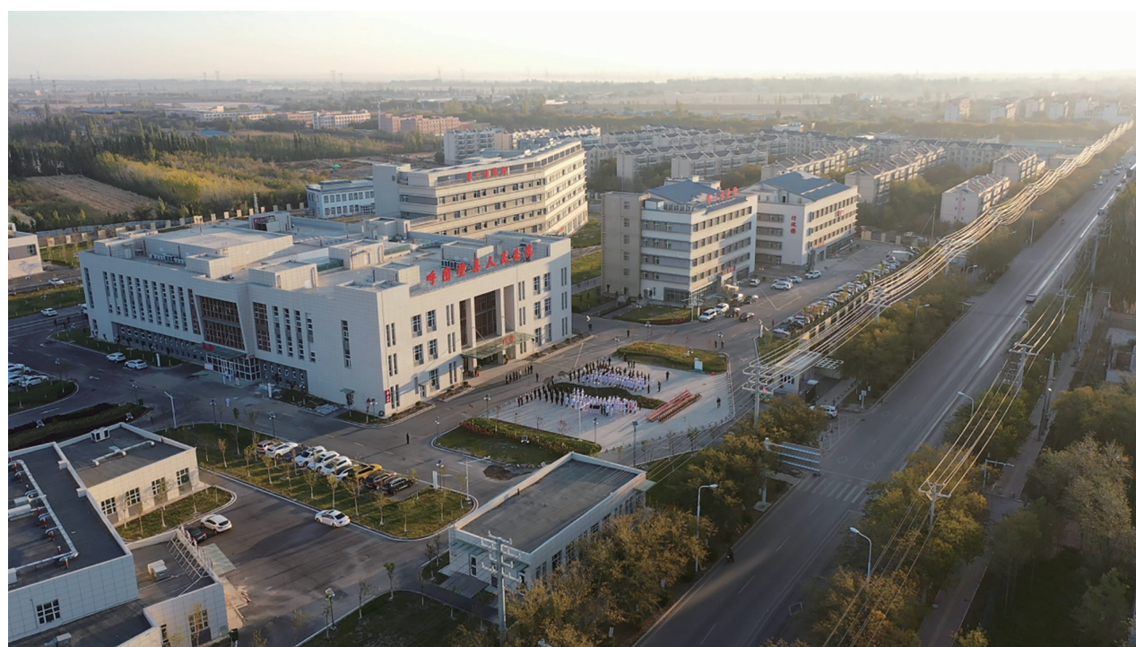
呼图壁县总医院人民医院分院新院区。 □松哈尔·努尔阿不力摄
