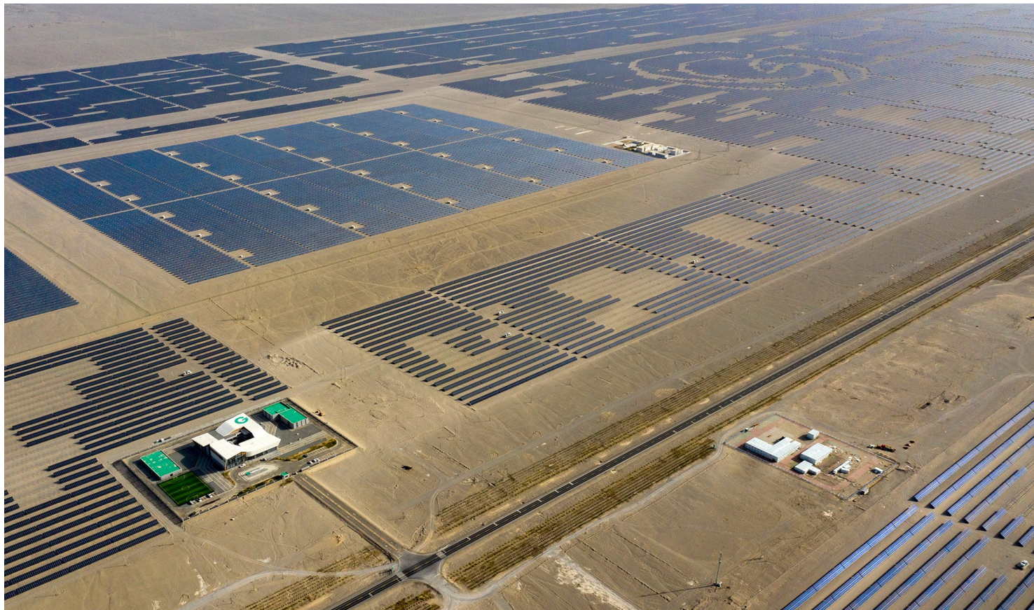
巴音郭楞蒙古自治州若羌县拍摄的中国绿发新疆中绿电若羌400万千瓦光伏项目（无人机照片）。该项目每年可发电69.08亿千瓦时，满足新疆200万户家庭用电需求。
