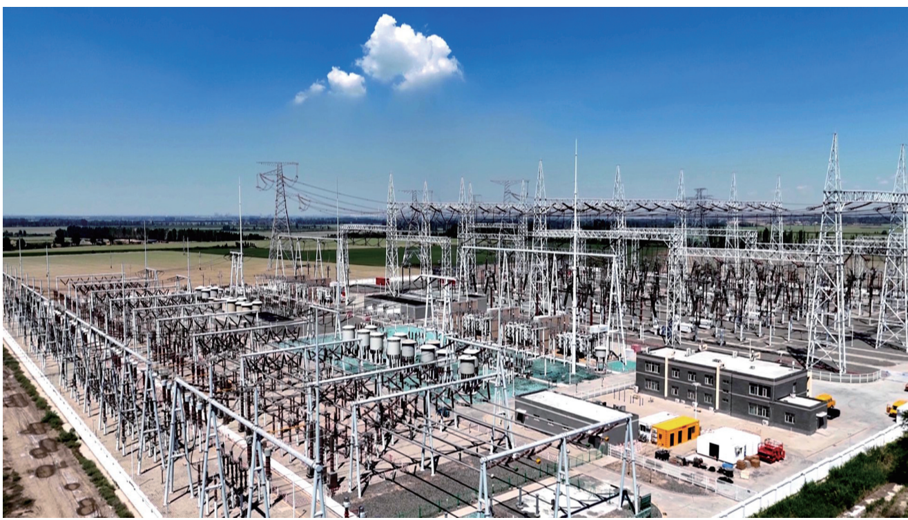
图为玛纳斯升压汇集站220千伏光伏送出工程施工现场。
