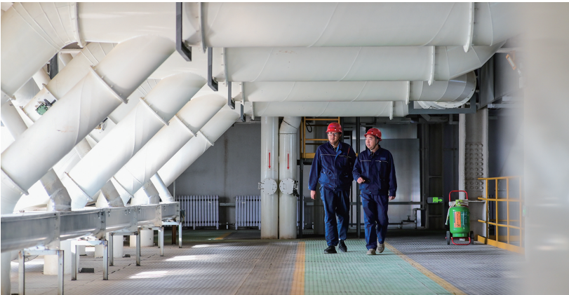
工作人员查看管网情况。
