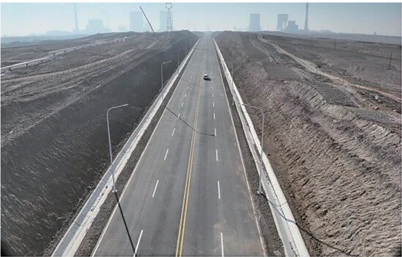
准东开发区西黑山至国能煤制气进场道路。
