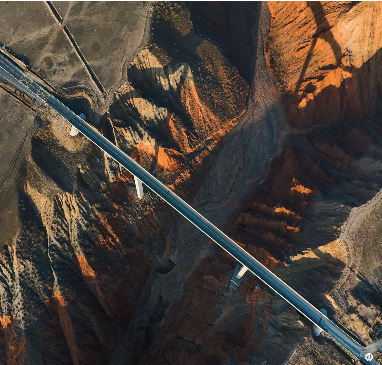
图①:11月1日,俯瞰呼图壁县齐古大桥。 图②:11月1日,呼图壁县,百里丹霞景区山脉在氤氲雾气中若隐若现。 图③:11月1日,呼图壁县,百里丹霞景区宛如一幅写意水墨画。 图④:11月1日,呼图壁县,百里丹霞景区山脉与齐古大桥相映成趣。
