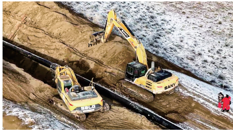
准东煤制天然气管道一期干线工程施工现场，两台挖掘机正在作业。
