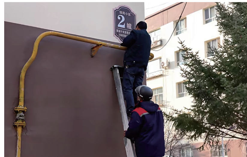
近日，奇台县信苑小区，施工人员正在安装新的楼栋牌。
