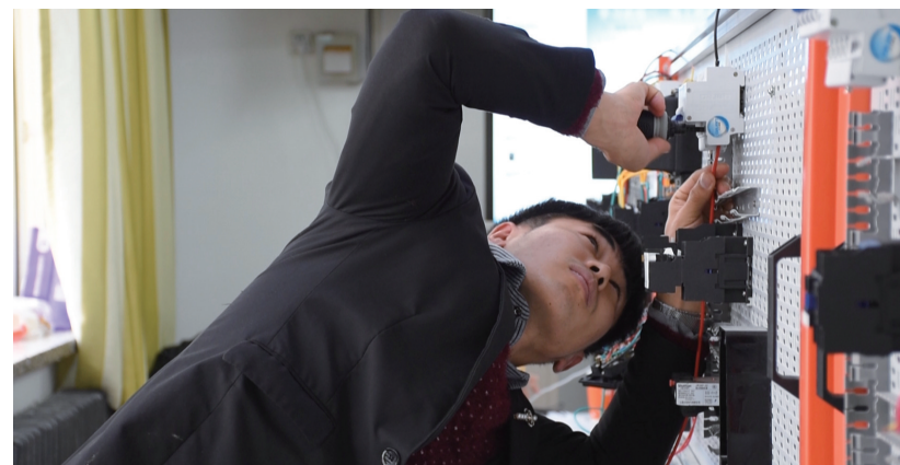
近日，在昌吉市技工学校实训室，电工培训班的学员正在进行接线、调试等实训操作。
