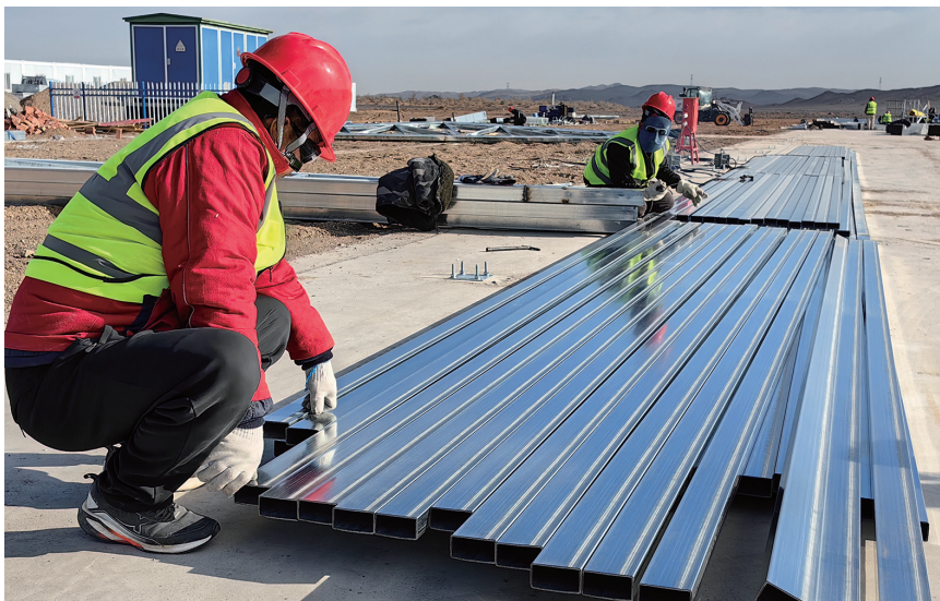
工人们在奇台县红业物业服务生活服务有限公司生活设施改造项目现场加紧施工。 □本报记者 刘辉摄
