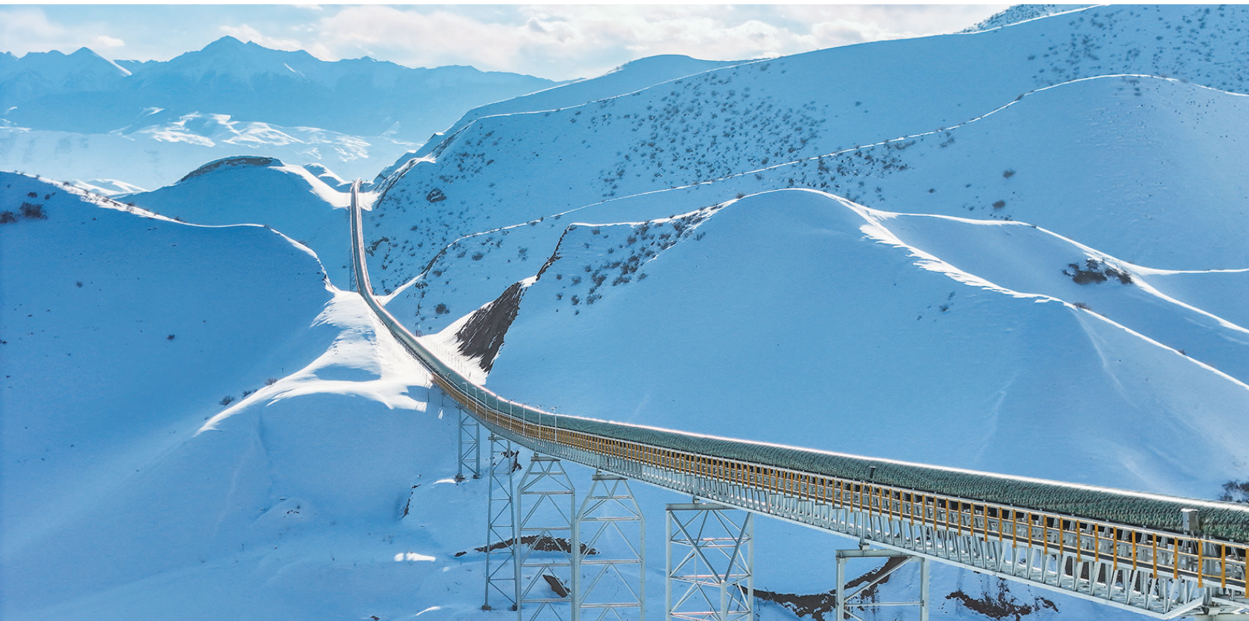
12月26日，在呼图壁县南部山区，新疆首条采用AI智能巡检技术的输煤廊道穿越山间。这条全疆最长、海拔落差最大的山区越野输煤廊道近日投运，采用全封闭式输送系统，结合AI智能巡检技术，年运力达700万吨，实现了“煤从空中走，运煤不见煤”。
