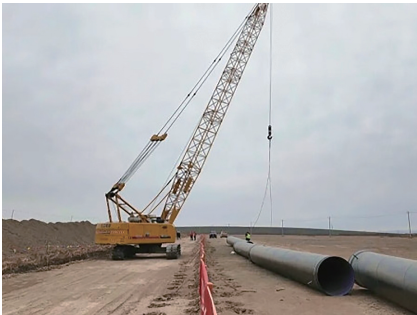
近日,木垒县雀仁井中型灌区续建配套与现代化改造工程正有序施工。
