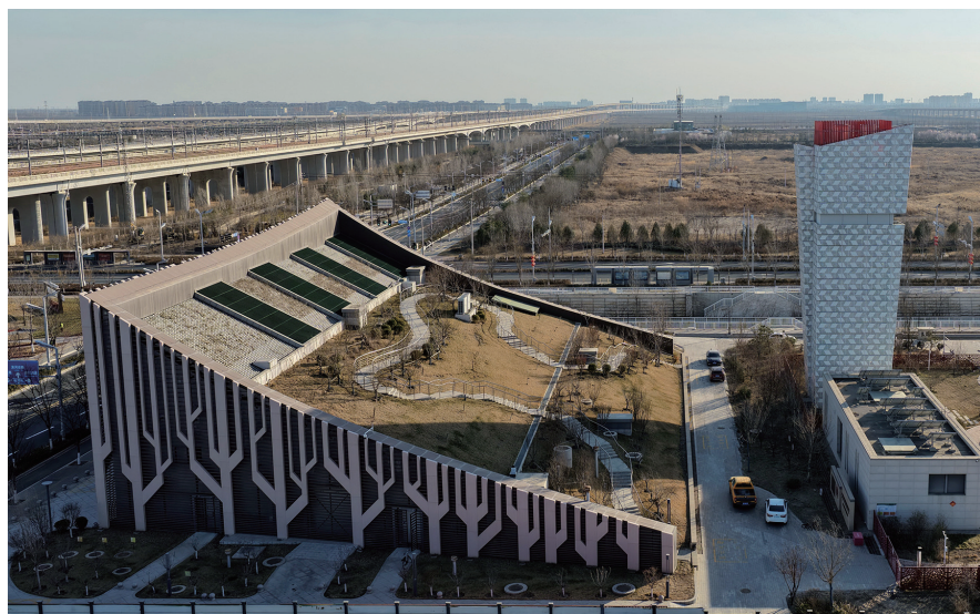
这是3月18日拍摄的河北雄安新区“城市森林”——荷露110千伏变电站外景（无人机照片）。该站为半地下户内变电站，采用城市森林设计理念，形成一片生态、绿色、自然、开放的景观空间。
