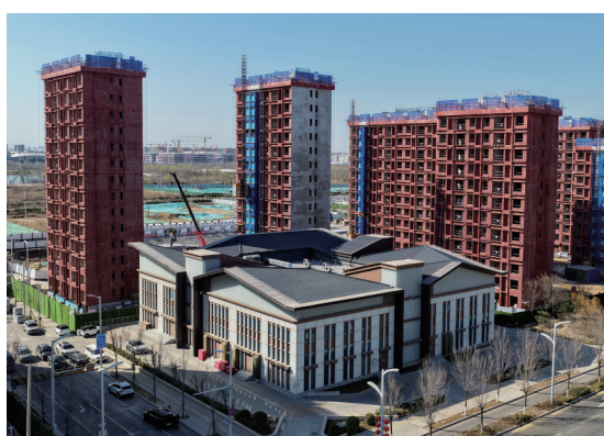
这是3月18日拍摄的河北雄安新区“鸿渐之翼”——鸿渐110千伏变电站外景（无人机照片）。该站结合雄安新区创新坊片区结构设计，融入周边环境。
