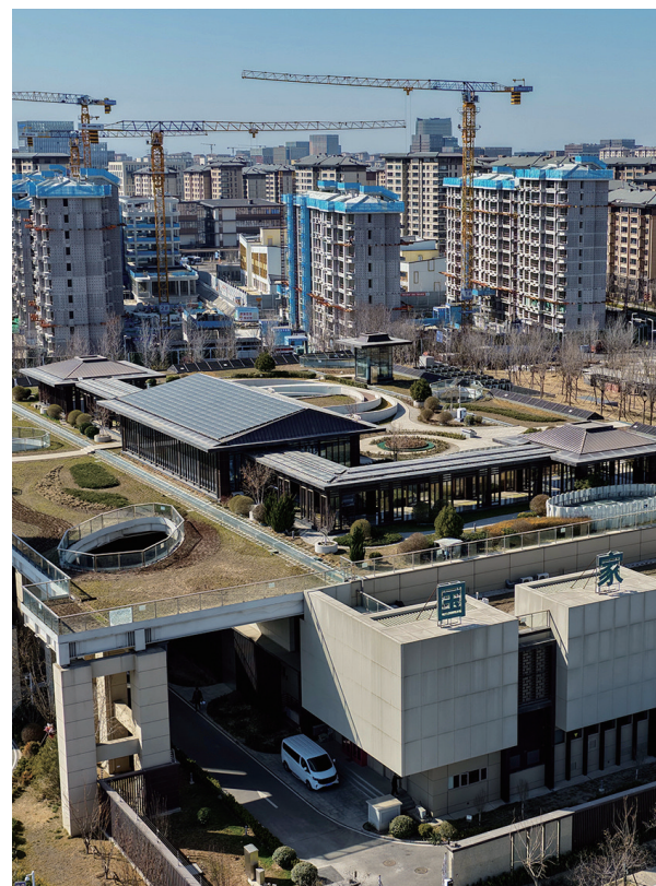
这是3月18日拍摄的河北雄安新区“智慧能源立方”——刷村220千伏变电站外景（无人机照片）。该变电站屋顶覆土建设成公园，形成与城市融合共生的图景。
