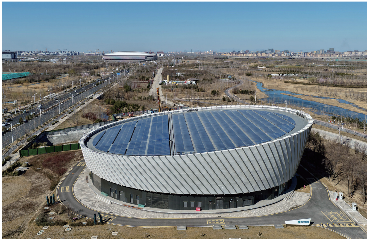
这是3月18日拍摄的雄安新区复兴220千伏变电站外景（无人机照片）。该变电站设计方案融合了海绵城市、碳足迹管理、能耗重组等8项绿色建设解决方案，采用智能化系统、水循环系统、零碳监测系统15项低碳技术，实现全生命周期“近零碳”。
