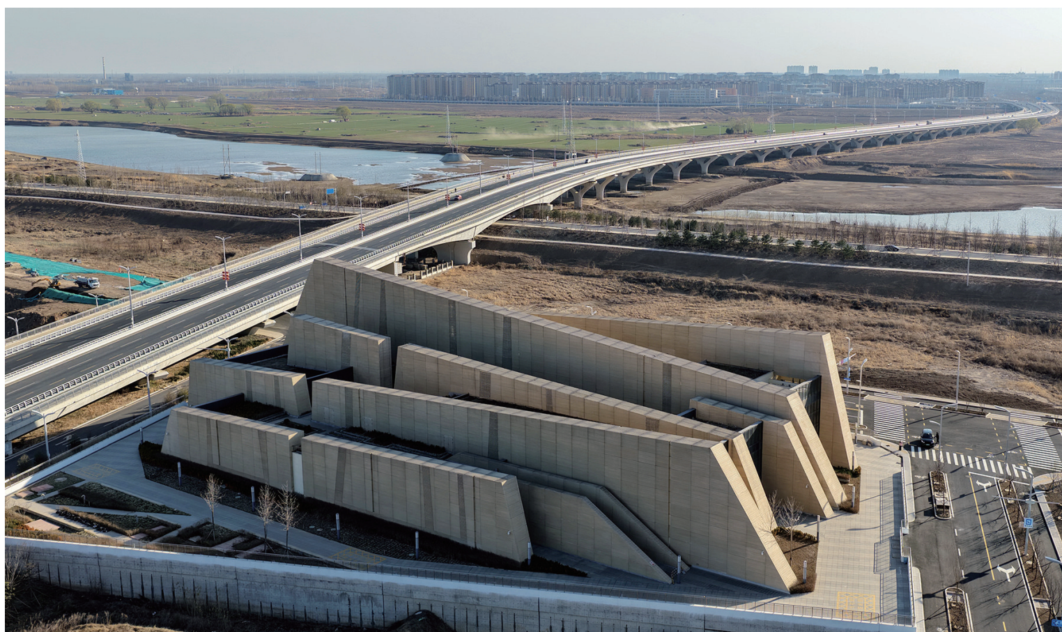
这是3月18日拍摄的河北雄安新区“山水城市”——管西220千伏变电站外景（无人机照片）。该站应用“海绵城市技术”建设的变电站，将屋顶景观公园与海绵变电站有机结合，通过“渗、滞、蓄、净、用、排”一系列措施，对雨水进行回收、净化、储存再利用。
