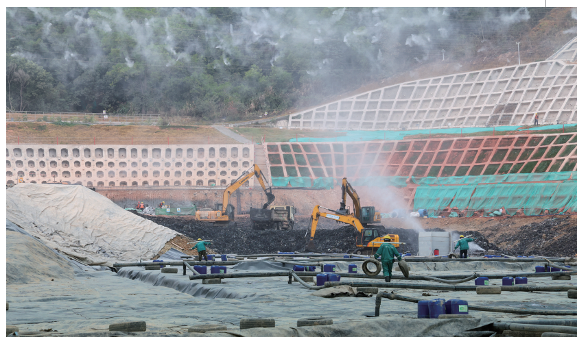
在玉龙岗垃圾填埋场环境修复工程现场，地表防渗膜与导排管网，有效收集处理渗滤液(1月30日摄)。
