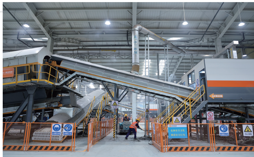
在玉龙岗垃圾填埋场环境修复工程筛分车间，智能筛分设备将垃圾分离为腐殖土、轻质物和无机骨料，腐殖土无害化后用于绿化，无机骨料制砖，轻质物转运焚烧发电(1月30日摄)。
