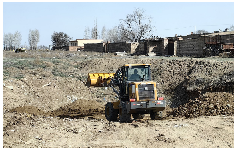
4月7日，垃圾坑回填作业现场。
