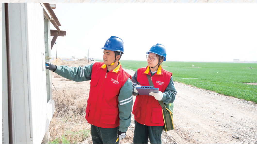
4月10日,昌吉市榆树沟镇曙光村,国网昌吉供电公司榆树沟供电所员工对农用配电线路、排灌设备进行逐一排查消缺。□本报记者 何龙摄
