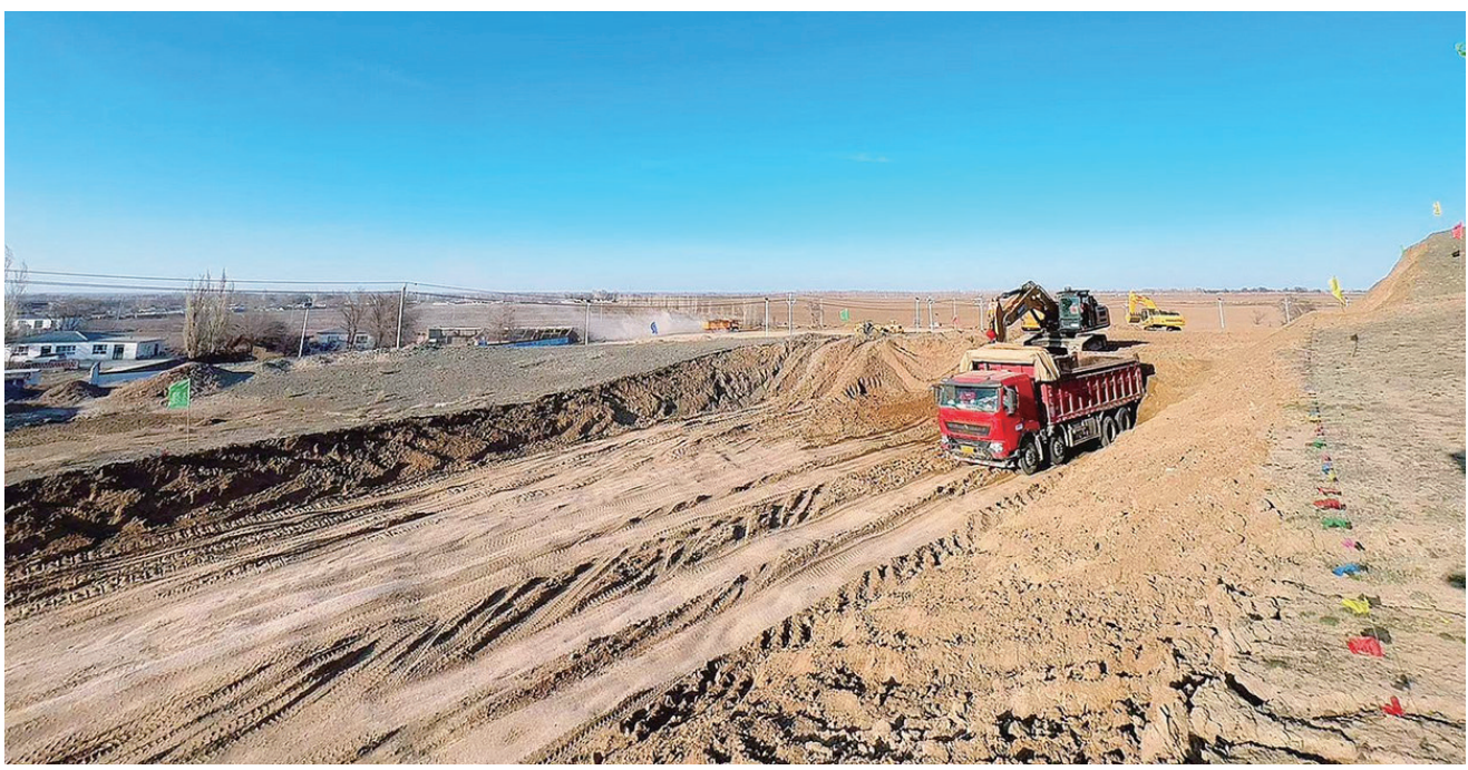
吉木萨尔县X183线公路改扩建工程建设现场。
