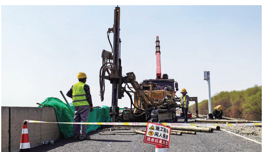
4月11日,在呼图壁县大海子水库,施工工人正在进行浸润线监测断面钻孔施工。
