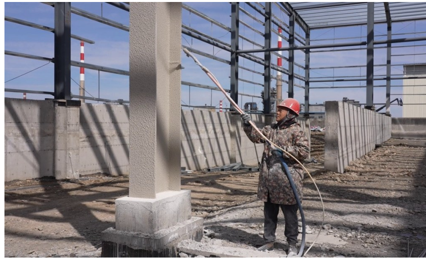
4月26日，在项目建设现场，工人正在进行内墙喷涂作业。
