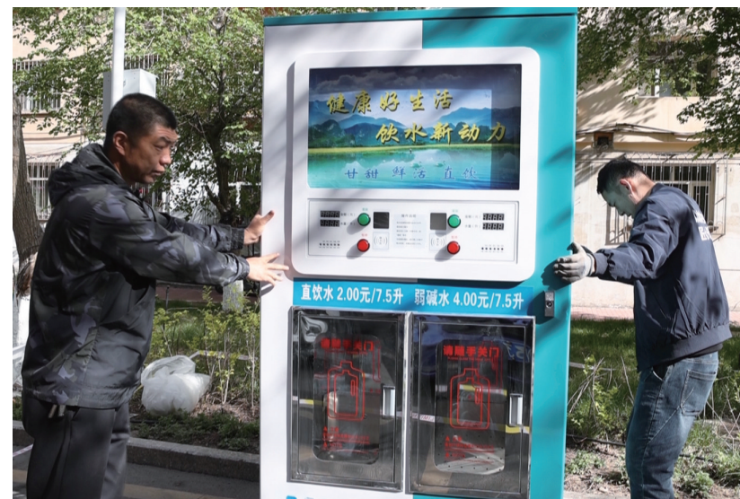
近日，工作人员在昌吉市一小区安装直饮水设备。
