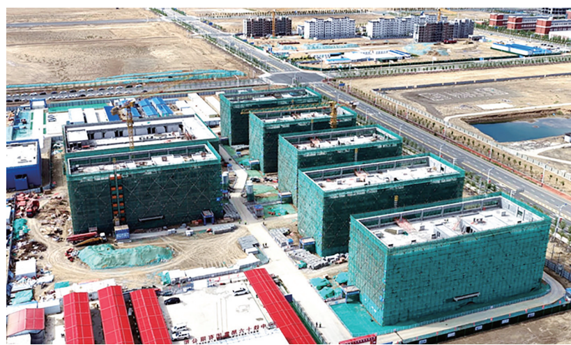
究矿其能生活服务项目建设现场。
