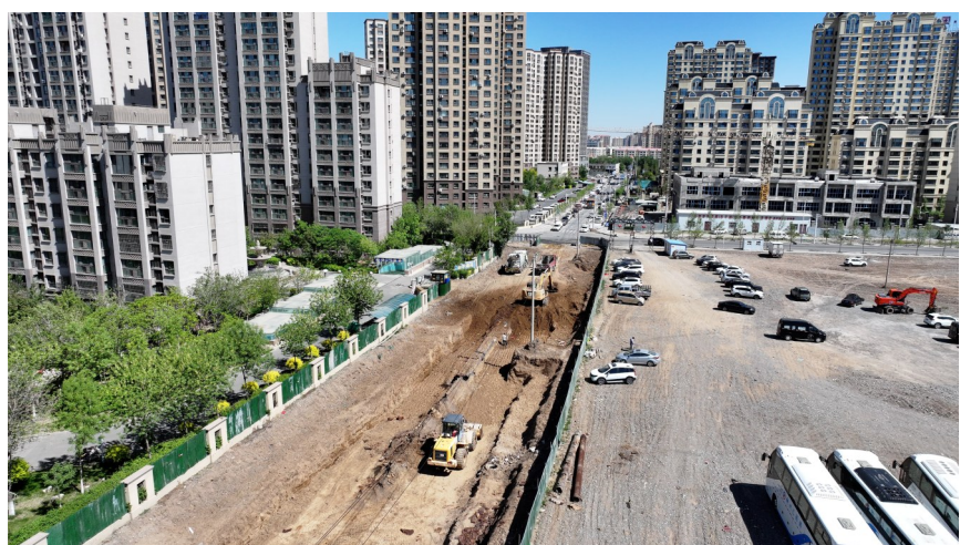
5月24日,昌吉市中山路东侧规划路(乌伊路—商城路)道路工程项目现场一片繁忙景象。 刘华摄
