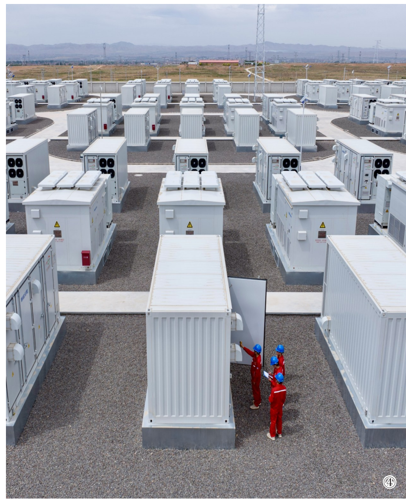
图④：5月19日，在位于宁夏同心县的同心县妙岭1GW/2GWh新型镍氢混合共享储能示范项目，工作人员进行巡检(无人机照片)。
