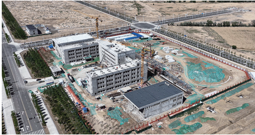
右图:准东开发区芨芨湖学校建设现场。 □张梓扬摄
